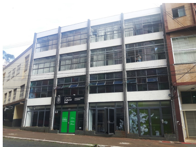
Vista recente da edificação, 2017. Fonte: Diretoria de Patrimônio Histórico-Cultural, PML
