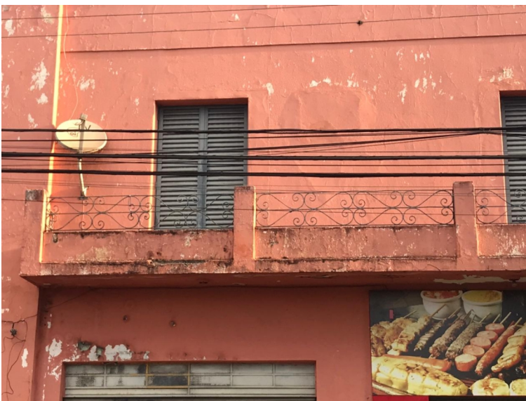
Registro fotográfico de 2021 - Detalhes do guarda-corpo (edifício 2).
