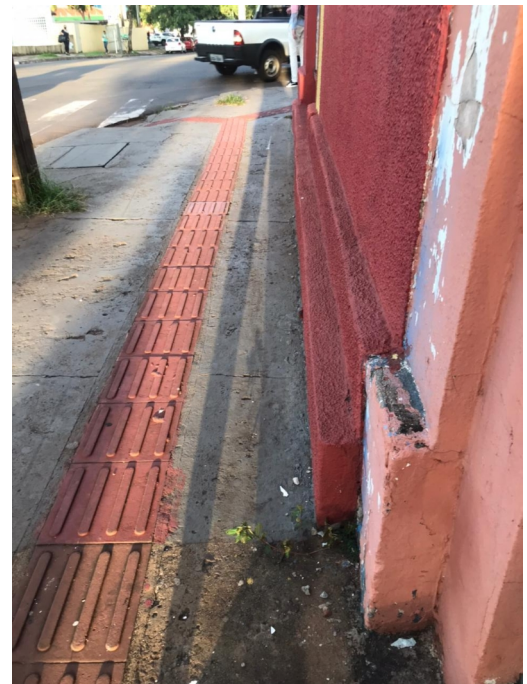
Registro fotográfico de 2021 - Detalhe da base (edifício 1).
