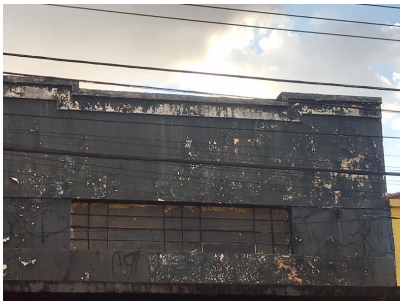
Registro fotográfico de 2021. Detalhe da platibanda e das aberturas.
