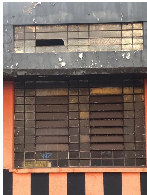
Registro fotográfico de 2021. Detalhe das aberturas do lado direito.
