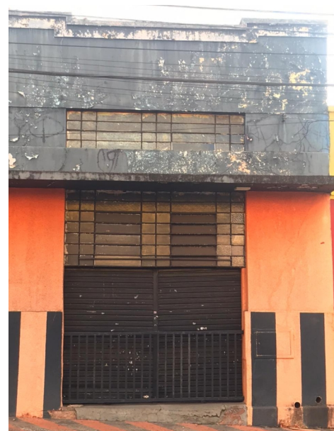
Registro fotográfico de 2021. Detalhe das aberturas do lado esquerdo.
