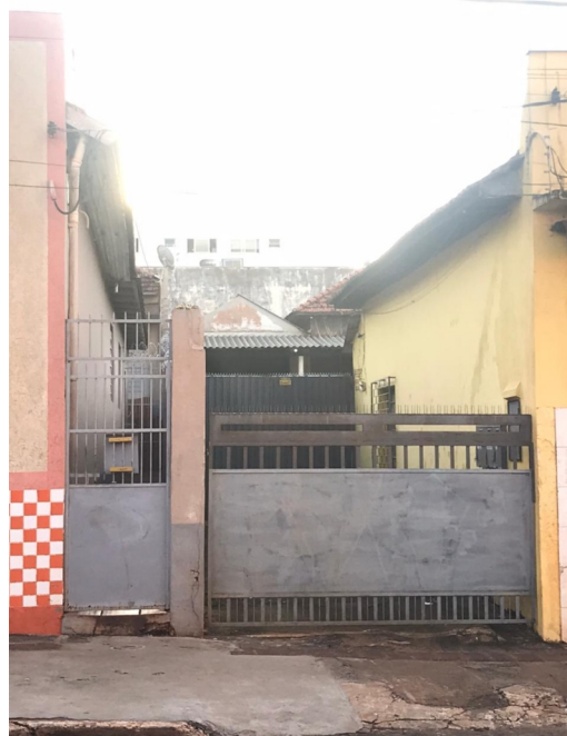
Registro fotográfico de 2021 - Detalhe do acesso ao edifício 2.
