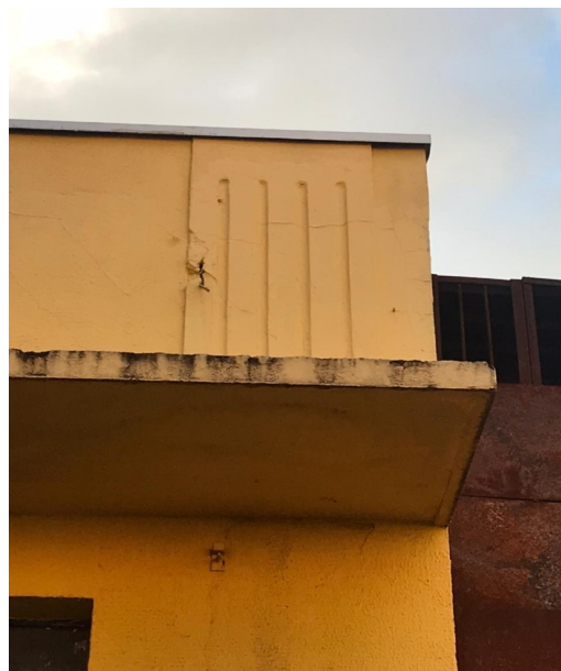
Registro fotográfico de 2021 - Detalhe da platibanda e da marquise (edifício 1).
