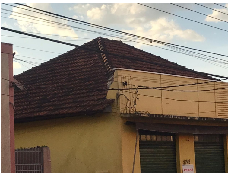
Registro fotográfico de 2021 - Detalhes da fachada e cobertura (edifício 1).
