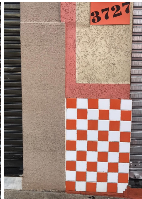
Registro fotográfico de 2021 – Detalhes de pintura e relevo da fachada (edifício 3).
