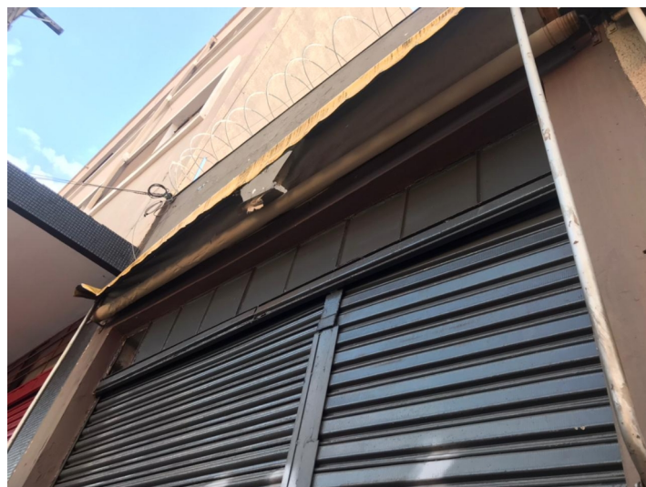
Registro fotográfico de 2021 – Detalhes da porta de acesso em ferro rolante (edifício 3).
