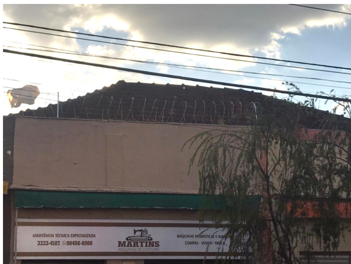
Registro fotográfico de 2021 – Detalhes de frisos em relevo na platibanda (edifício 3).
