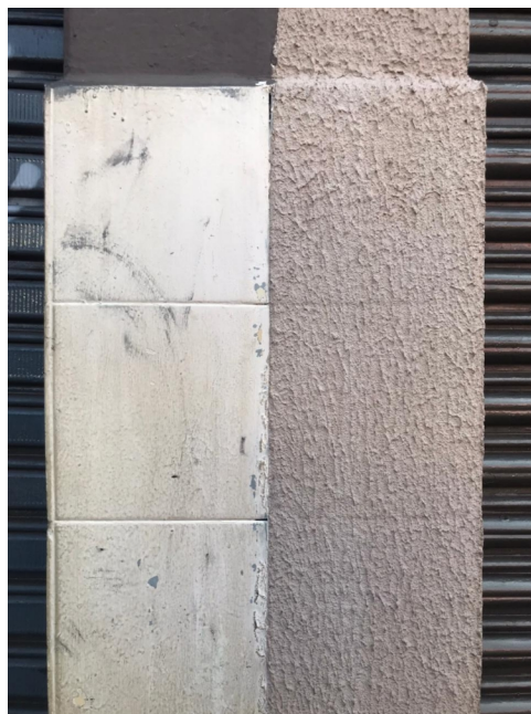
Registro fotográfico de 2021 – Detalhes de pintura e relevo da fachada (edifício 3).
