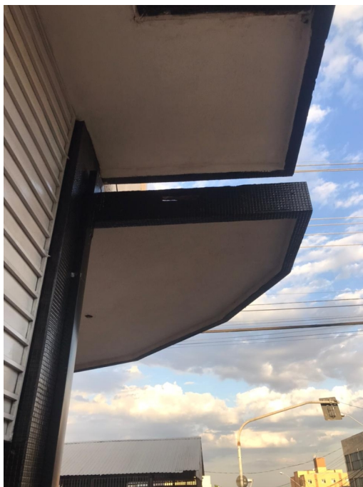
Registro fotográfico de 2021 – Detalhe da marquise no pavimento térreo (edifício 3).
