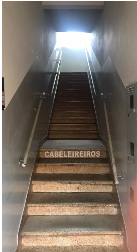
Registro fotográfico de 2021 – Escada de acesso ao primeiro e segundo pavimento (edifício 3).
