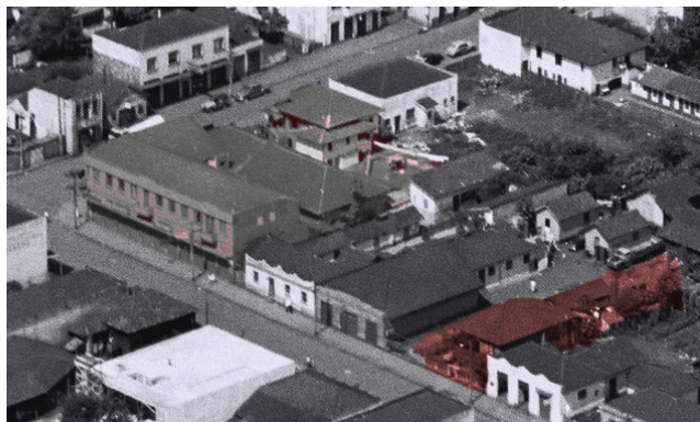
Registro fotográfico da década de 1950 (edificação demolida) Autor: Yutaka Yasunaka. Fonte: MHL / Acervo Foto Estrela (editado)
