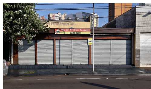
Registro fotográfico de 2020 Lote 1 / Casa das Bombas e Ferragens (1) Autora: Nathália I. N. Shimizu Fonte: Acervo do Proj. Pesq. 10102/ UEL (Rodrigues, 2019)
