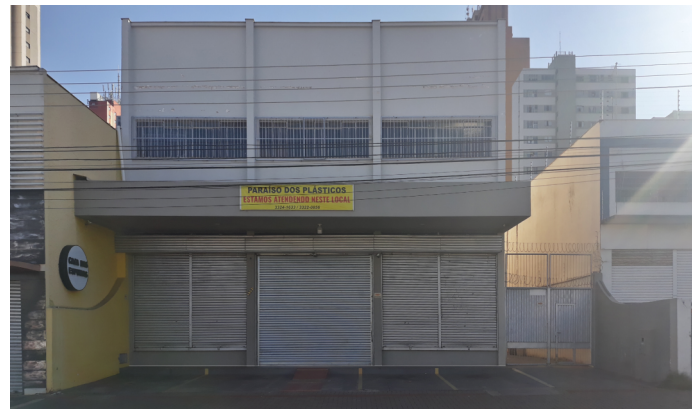
Registro fotográfico de 2020 - Autora: Nathália I. N. Shimizu Fonte: Acervo do Proj. Pesq. 10102/ UEL (Rodrigues, 2019)
