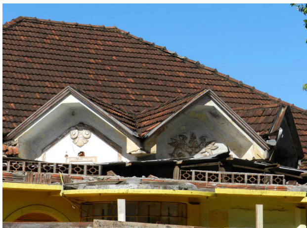
Foto dos frontões no começo da demolição, 2013 Fotógrafo: José RoberStones Pieretti
