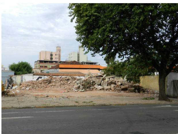
Demolição, 2013 Fotógrafo: José RoberStones Pieretti
