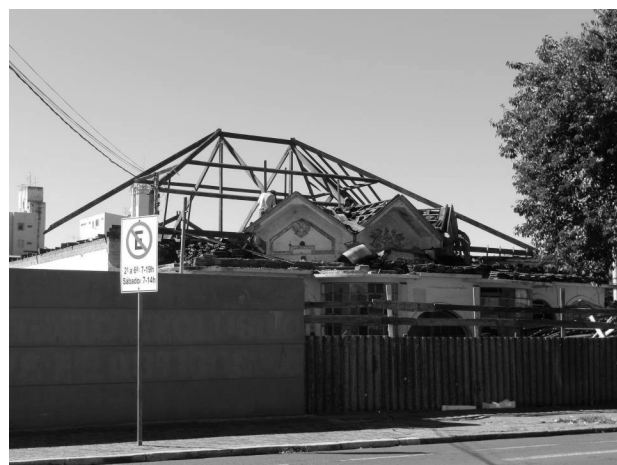
Retirada das telhas, 2013 Fotógrafo: José RoberStones Pieretti
