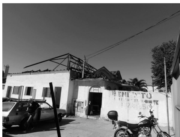
Foto da remoção do telhado, visto da lateral, 2013 Fotógrafo: José RoberStones Pieretti
