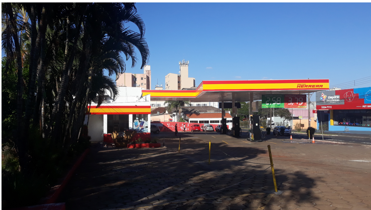
Vista do posto de gasolina da calçada da Av. Duque de Caxias, 2020
