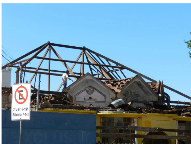
Foto dos frontões durante a retirada das telhas, 2013 Fotógrafo: José RoberStones Pieretti
