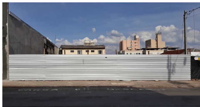
Registro fotográfico de novembro de 2019, após a demolição Autora: Nathália Isabella Nagao Shimizu. Fonte: Acervo do Projeto de Pesquisa 10102/ UEL (Rodrigues, 2019)
