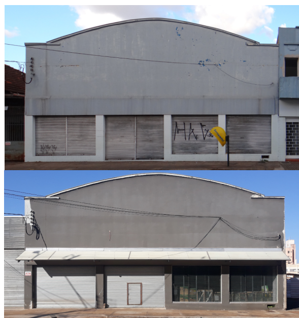
Registros fotográficos de 2018 (acima, antes da reforma) e 2020 (abaixo, durante reforma) Autora (foto 2): Nathália Isabella Nagao Shimizu Fonte: Acervo do Projeto de Pesquisa 10102/ UEL (Rodrigues, 2019)
