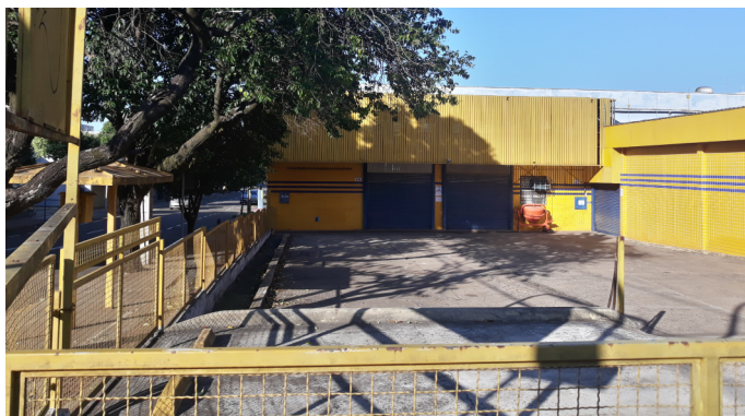
Registro fotográfico de 2020, fachada lote 7 frente para Avenida Duque de Caxias. Autora: Nathália I. N. Shimizu Fonte: Acervo do Projeto de Pesquisa 10102/ UEL (Rodrigues, 2019)
