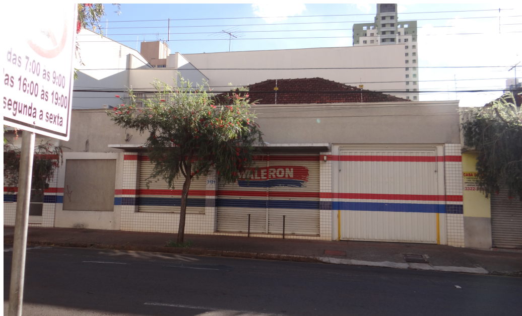
Registro fotográfico de 2019 – Portas metálicas/portão fechados
