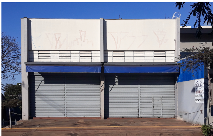
Registro fotográfico de 2019 Frente para Av. Duque de Caxias Fonte: Projeto de Pesquisa 10152/UEL. Rodrigues, 2019. Edificação de 1987.
