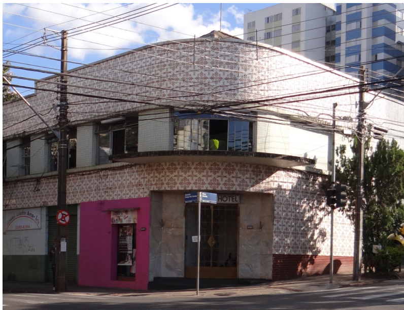
Esquina da edificação, 2017.
