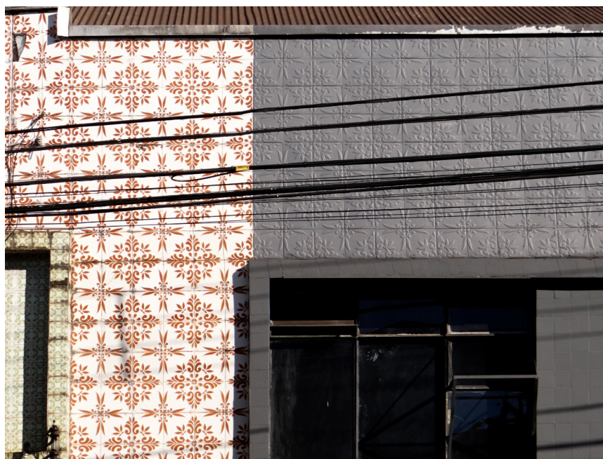
Detalhe dos materiais da fachada, 2017.
