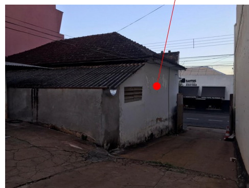
Registro fotográfico de 2021 – fundos prédio comercial (lote 02). Fonte: Rodrigues, 2021. Acervo do Projeto de Pesquisa 10102/UEL.
