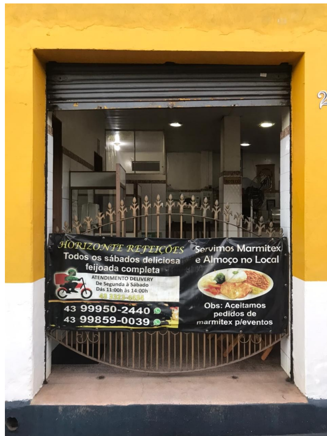
Registro fotográfico de 2021 – detalhe grade fachada principal. Fonte: Rodrigues, 2021. Acervo do Projeto de Pesquisa 10102/UEL.
