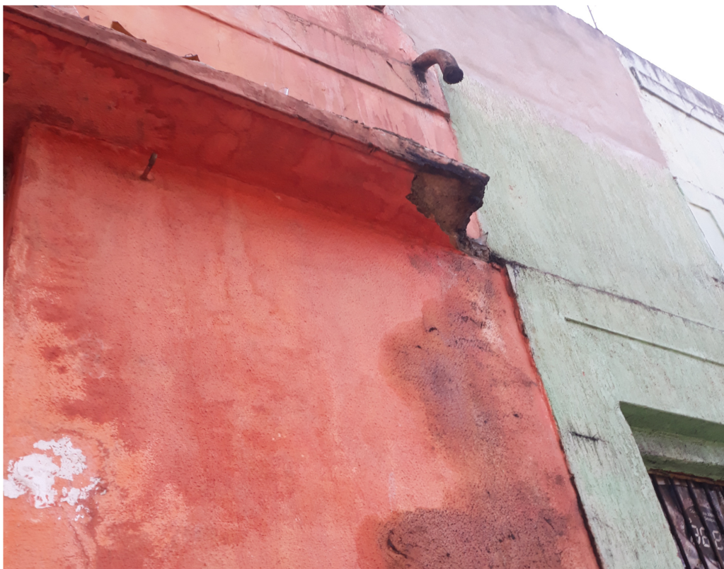
Registro fotográfico de 2019, Deterioração da pintura e da marquise Autora: Nathália I. N. Shimizu Fonte: Rodrigues, 2019
