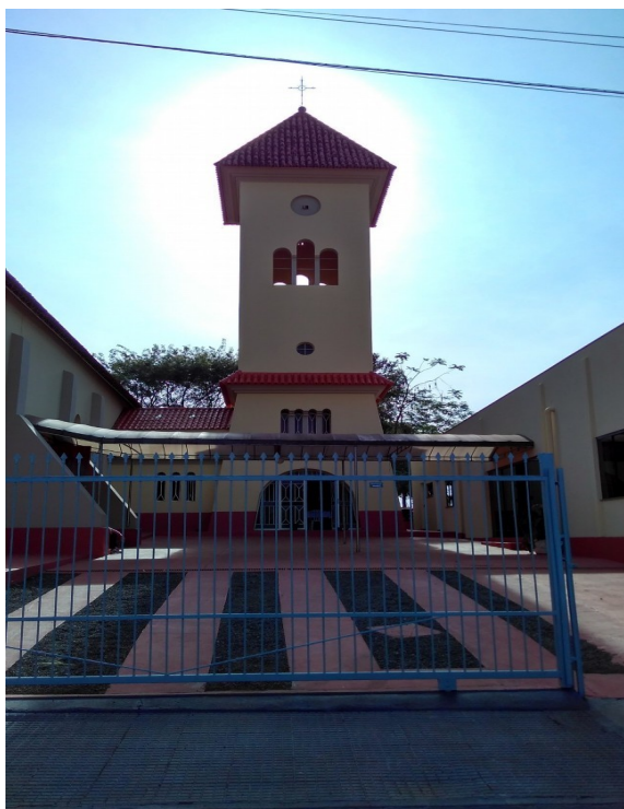
Vista da Torre
