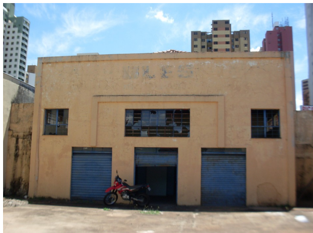
Fachada em 2008, antes da ocupação Fonte: Dir. de Patrimônio Histórico
