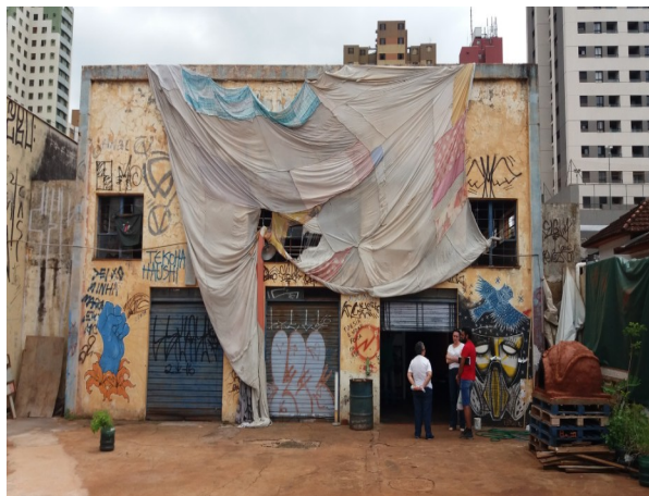
Fachada em 2017, depois da ocupação Fonte: Dir. de Patrimônio Histórico
