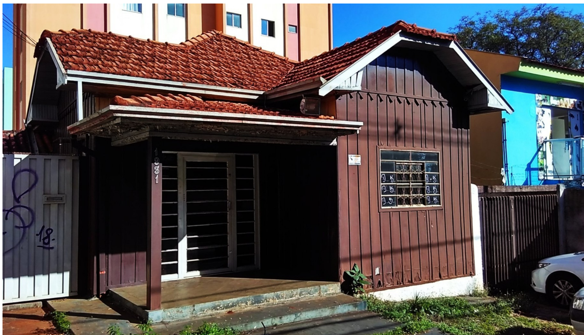
Vista geral da edificação.
