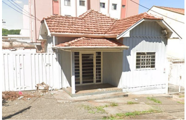
Vista frontal da edificação Fonte: Google Maps 2023. https://goo.gl/maps/eKxQTYotcxGNN4Cg7
