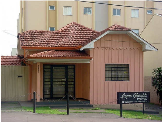
Vista frontal da edificação Fonte: Pesquisadores, 2003
