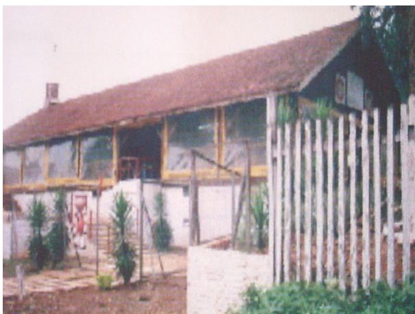
Fachada principal da antiga serraria Fonte: Trabalho final de graduação da arquiteta Ilzângela Keila de Almeida, 2003
