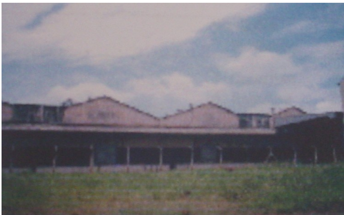
Vista geral do armazém.
