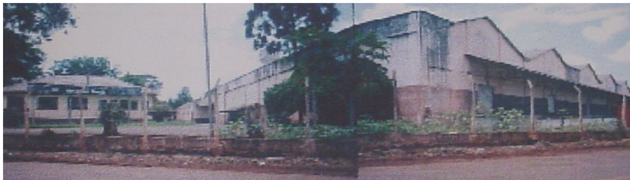
Vista geral do armazém.
