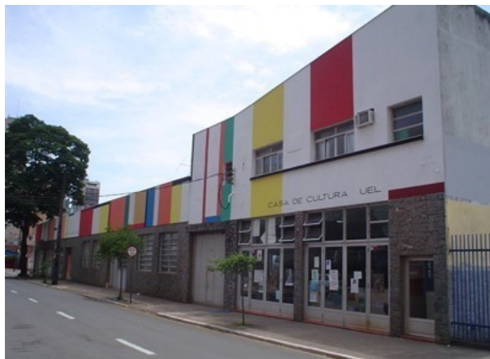
Foto Fachada Casa de Cultura. Fonte: Autores, 2005.
