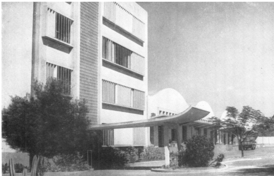
Aspecto de um dos prédios do Conjunto Industrial da Maltaria e Cervejaria Londrina.
