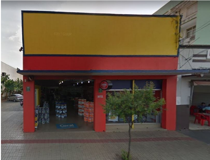
Fachada Fonte: Google Earth, 2017 https://goo.gl/maps/crjbx2tApNK1uKuH9
