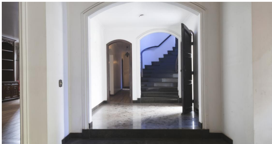
ENTRADA LATERAL E ESCADA PARA 2º PAVIMENTO
