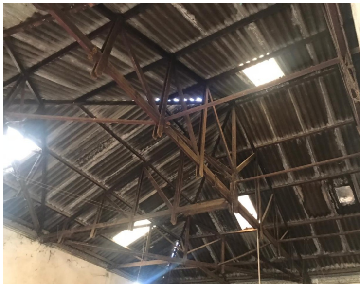
Registro fotográfico 2021 – Detalhes internos da cobertura
