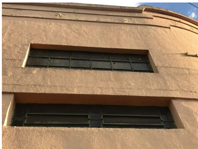
Registro fotográfico 2021 – Detalhes da fachada
