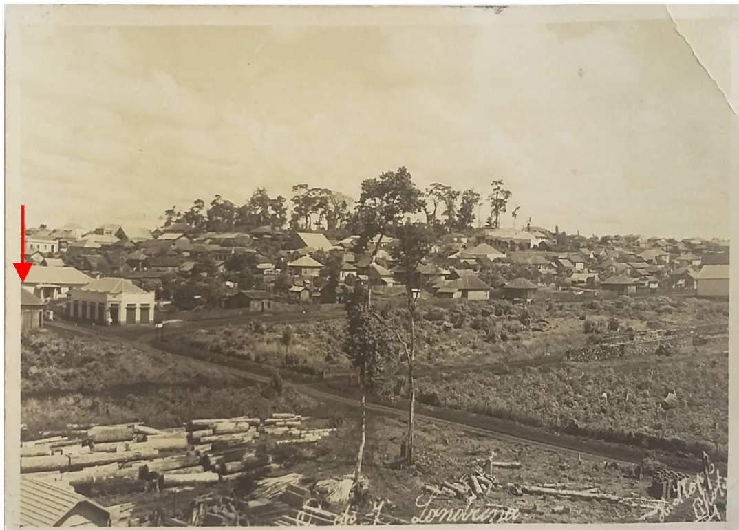
Registro fotográfico de 1935 arquivado na Biblioteca Central de Londrina – edifício de esquina em madeira (editado)
