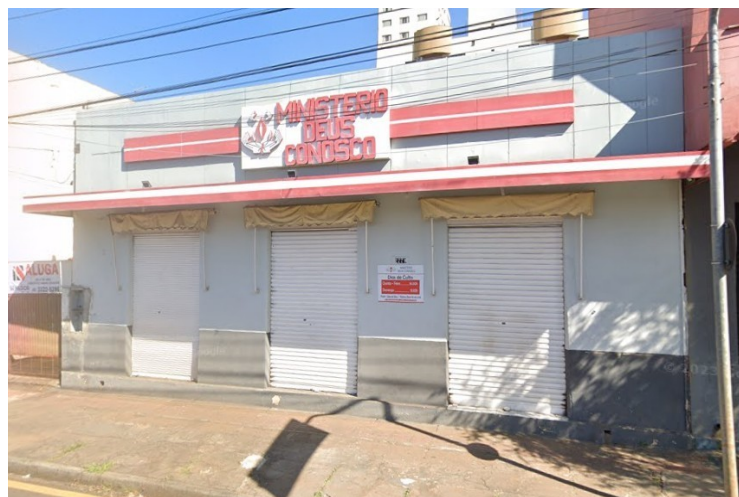
Fachada atualmente, 2023 Fonte: Google Maps. https://goo.gl/maps/4ABxmLVd7zxbUHMCA
