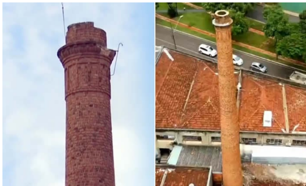
Chaminé da Serraria Mortari Fonte: Temlondrina Serraria Mortari
