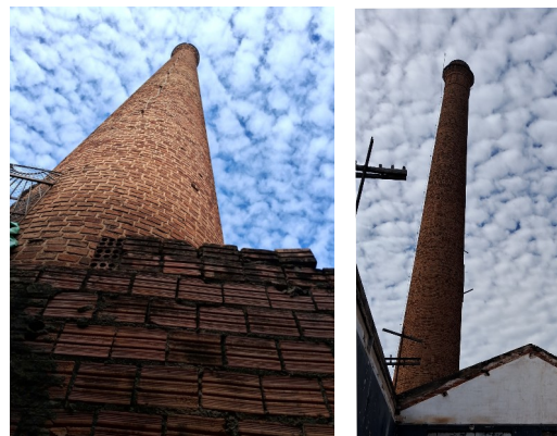
Chaminé da Serraria Mortari 01/2024
