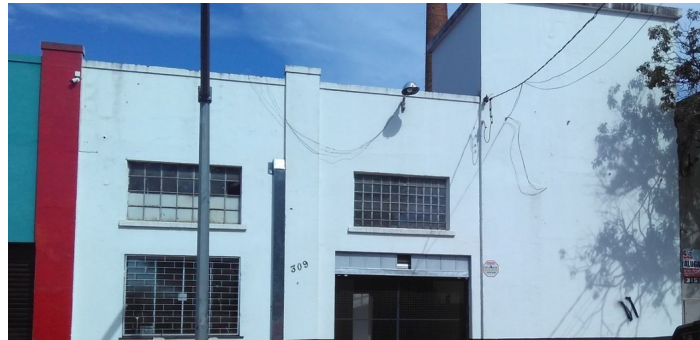
Fachada da edificação
