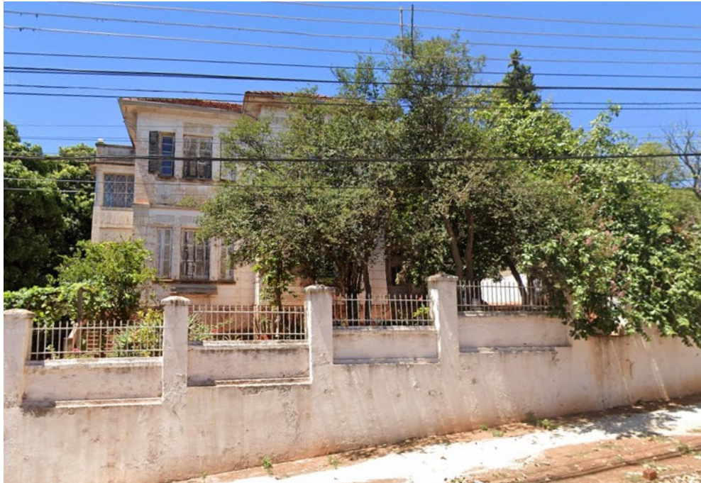
Imagem da Fachada 2021
