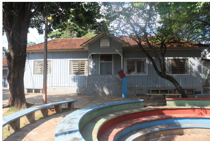
Fachada principal da Escola Municipal Padre Anchieta Fonte: Os autores, 2023
