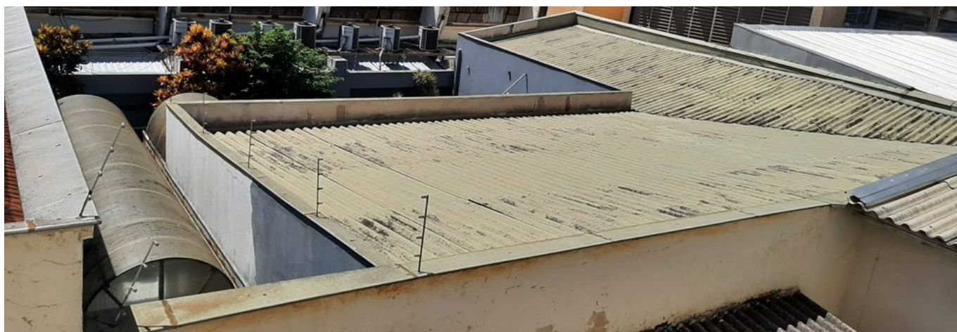
Cobertura – construção de 1967
