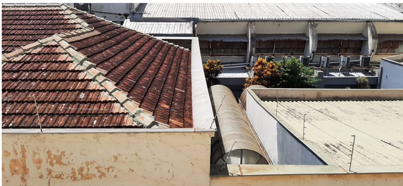
Cobertura – união das duas construções
