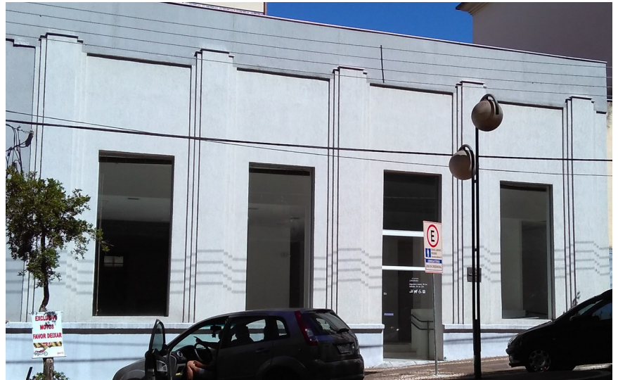
Fachada da edificação.
