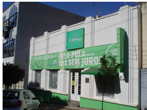
Fachada Brasil Telecom
