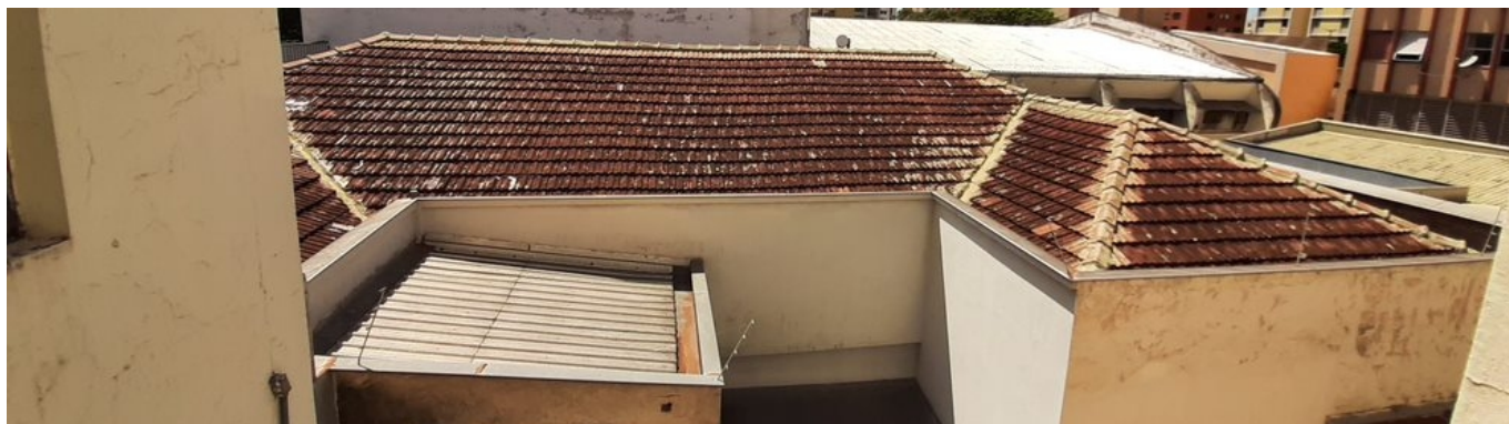
Cobertura – construção de 1947
