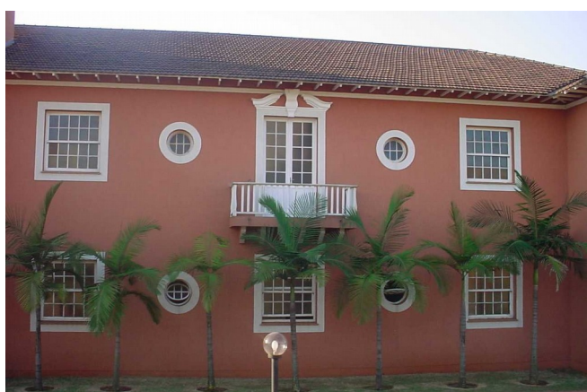
ESQUADRIAS FACHADA PRINCIPAL, 2004.
