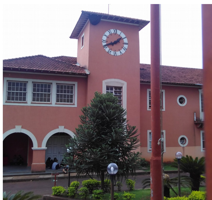
ESQUADRIAS FACHADA PRINCIPAL, 2018.
