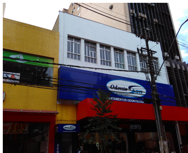
Vista atual da edificação, 2018 Fonte: Diretoria de Patrimônio Histórico.
