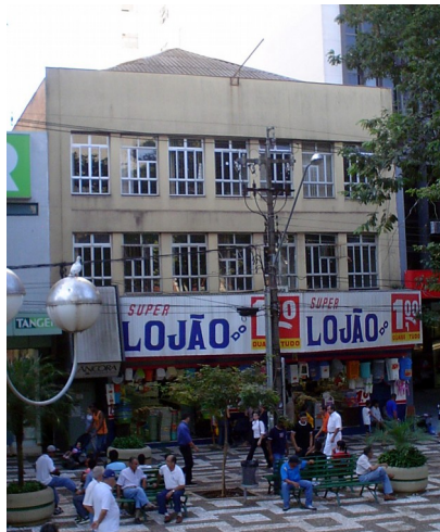
Vista da edificação Fonte: Autores, abril de 2005
