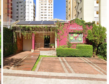
Fachada atual da edificação, jun. 2025 Fonte: Google Street View https://maps.app.goo.gl/uhzRFKoes4TIEMrT8
