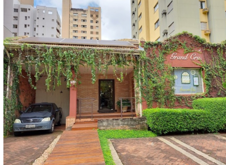
Fachada atual da edificação, 2023 Fonte: Foto autoral
