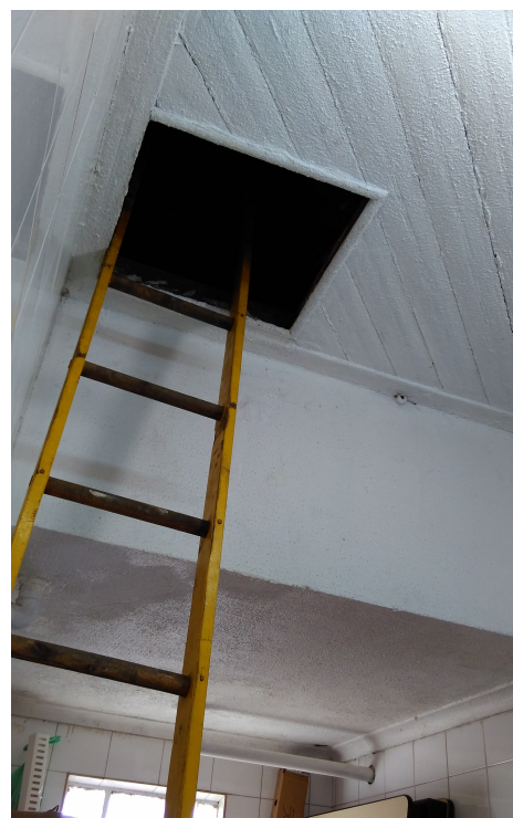
Forro da edificação. Fonte: Diretoria de Patrimônio, 2018.
