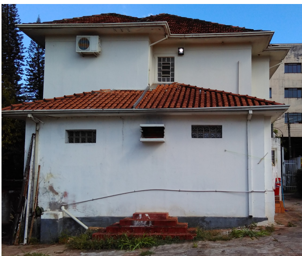
Vista traseira da edificação. Fonte: Diretoria de Patrimônio, 2018.
