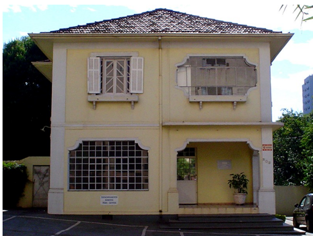
Vista frontal da edificação Fonte: Autores, 2005
