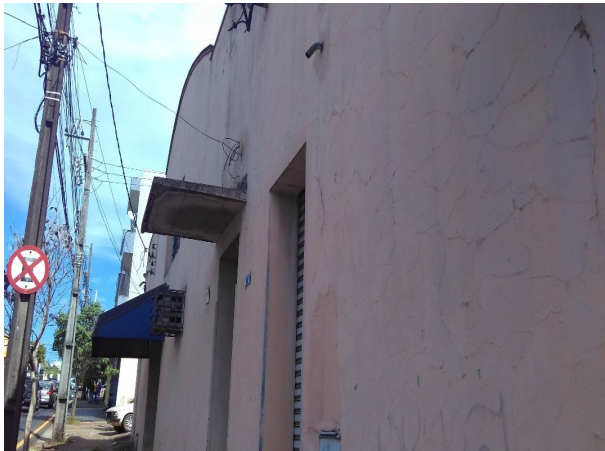
Detalhe marquise. Fonte: Aline Terra, 2018
