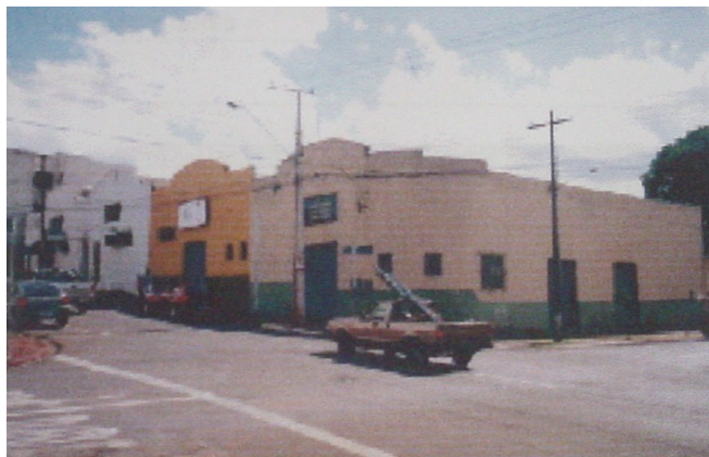
Vista geral do armazém. Fonte: Trabalho Final de Graduação da Arquiteta Ilzângela Keila de Almeida, 2003.
