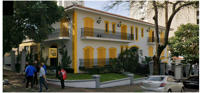
Fachada, junho de 2025. Fonte: Google Maps. Street View
