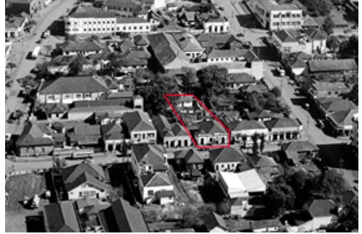
Registro fotográfico lote 4 da década de 1950 (edificação demolida) Autor: Yutaka Yasunaka. Fonte: MHL / Acervo Foto Estrela (editado)
