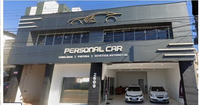
O edifício foi demolido e atualmente se encontra uma funilaria no local – 2023 Fonte: Google Maps. https://goo.gl/maps/HvUpbaf3ub1ahCfM6
