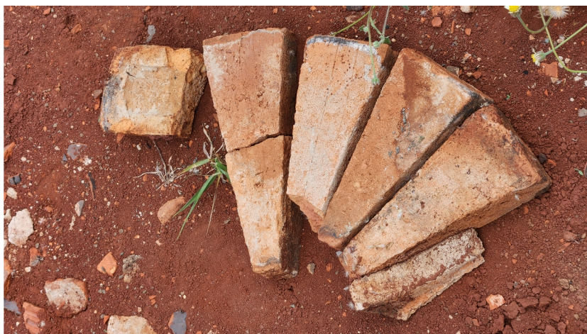
Tijolo cerâmico maciço angular utilizado na construção da Chaminé. Fonte: Autores (2024).
