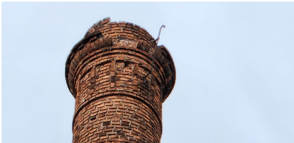
Coroa da Chaminé parcialmente demolida. Fonte: Autores (2024).
