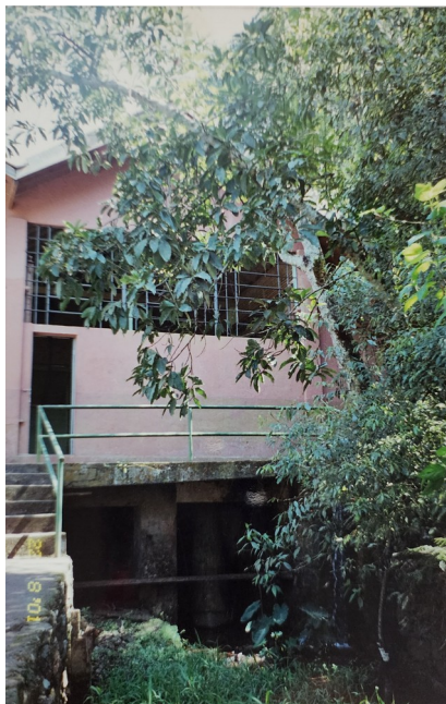
Fachada posterior da casa de máquinas onde havia o canal de fuga abaixo, 2001 Fonte: Acervo de Mangili Jr. (2025).
