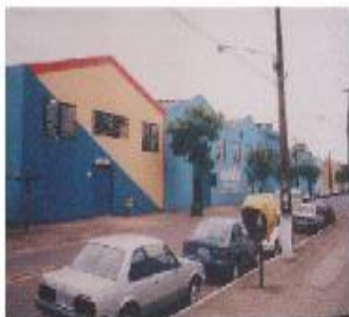
Vista geral do armazém. Fonte: Trabalho Final de Graduação de Arquiteta Izângela Kells de Almeida, 2003.
