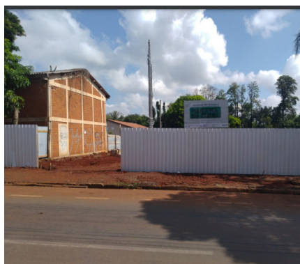
Construção PAM Sul Av. Guilherme de Almeida
