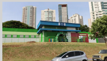
Concluída a Reforma da UBS Guanabara
