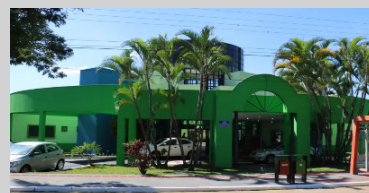
Conclusão da Ampliação e Reforma da Maternidade Municipal
