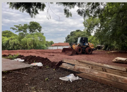
Início da construção dos Pronto Atendimentos das Regiões Norte, Sul e Leste
